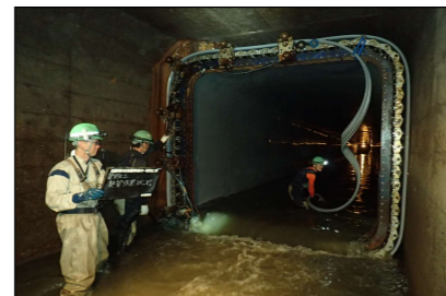
製管状況 (管内)
