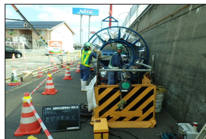
製管状況 (地上)
