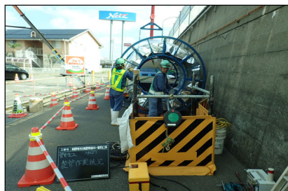
製管状況 (地上)
