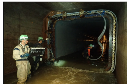
製管状況 (管内)
